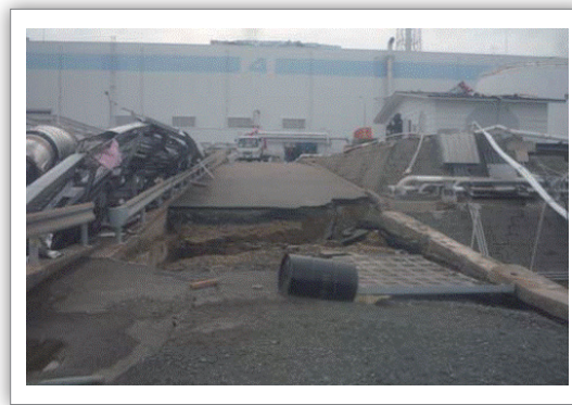
▲ 9級強震使福島電廠地面嚴重龜裂變形
