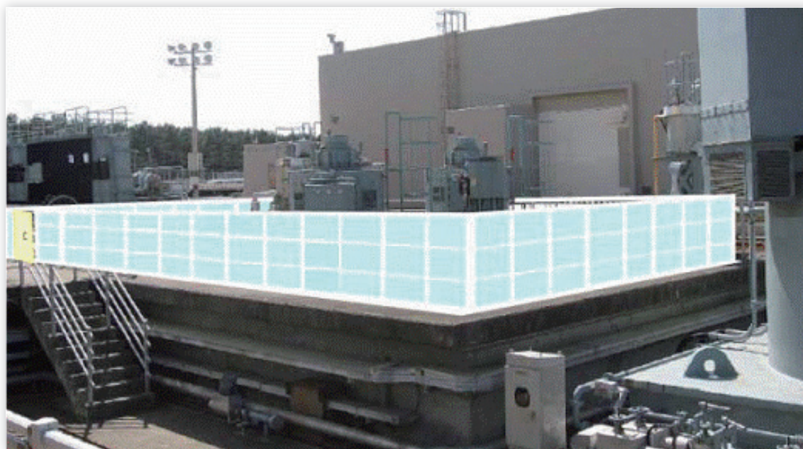
▲ 浜岡電廠海水幫浦區擋水牆示意圖
